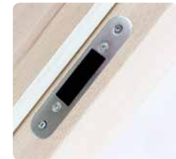
magnetyczna blacha zaczepowa z regulacją standardowe wyposażenie we wszystkich ościeżnicach bezprzylgowych
